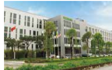
順德五沙生產基地 Wusha production base in Shunde
